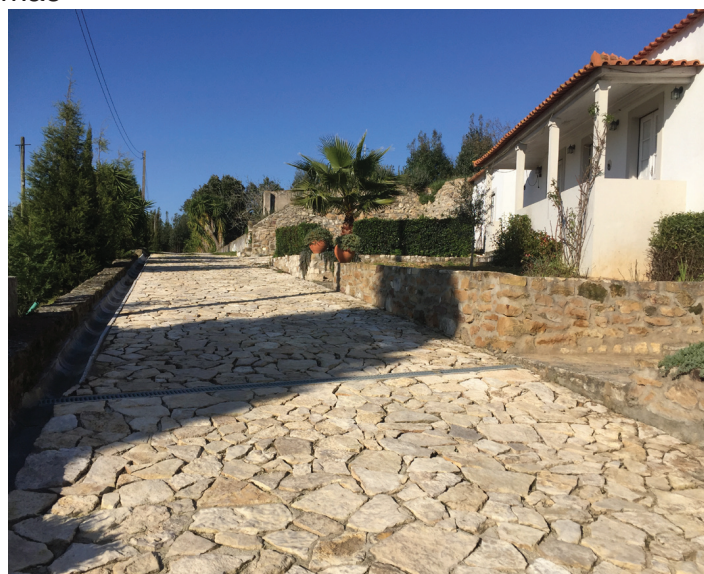
Casa de Visitas
